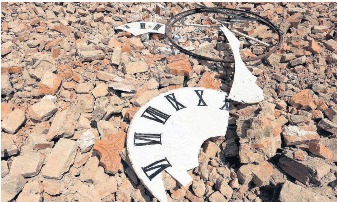
Teile der Kathedrale von Mirandola nach den Erdbeben in Italien. In der Provinz Modena wurden 45 zerstörte Kirchen gemeldet.
